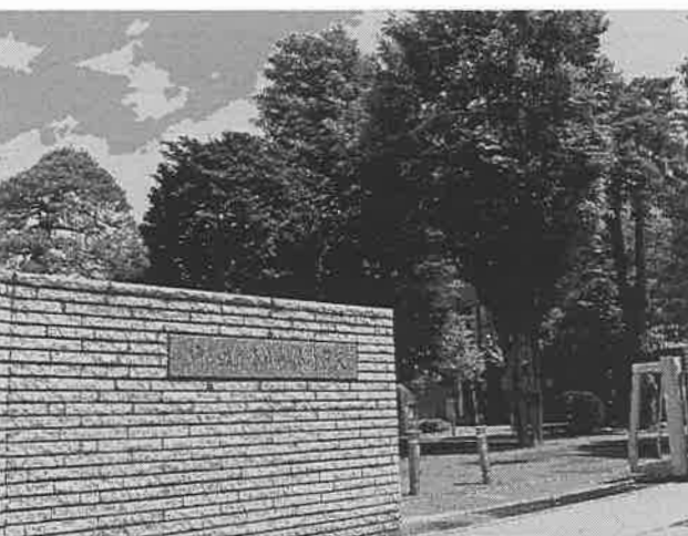
春日部高校の旧校門。1999年に現在の3代目校舎が完成した後もそのまま残された。後ろに広がる地域開放広場は市民が自由に散策、通り抜ける
